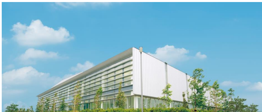
プール棟外観
